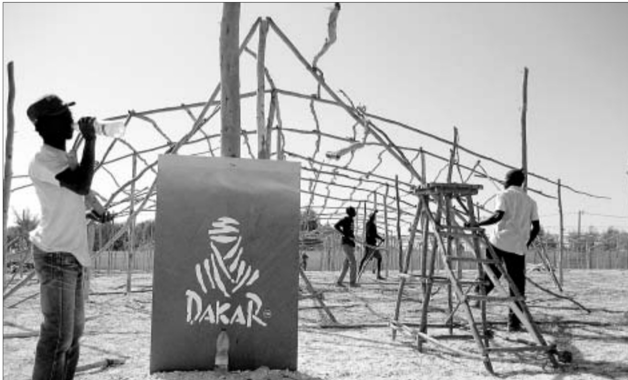
Un operario desmonta una de las carpas en la llegada del rally al Lago Rosa.
